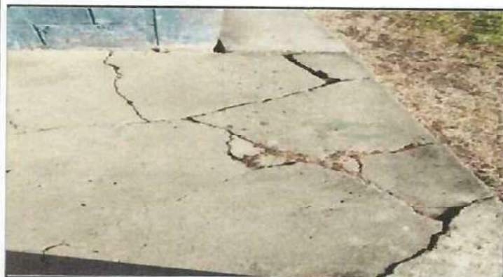
Foto 3: Este es el corredor de enfrente, lado sur, completamente requetrajado y es necesario suplir el material.
