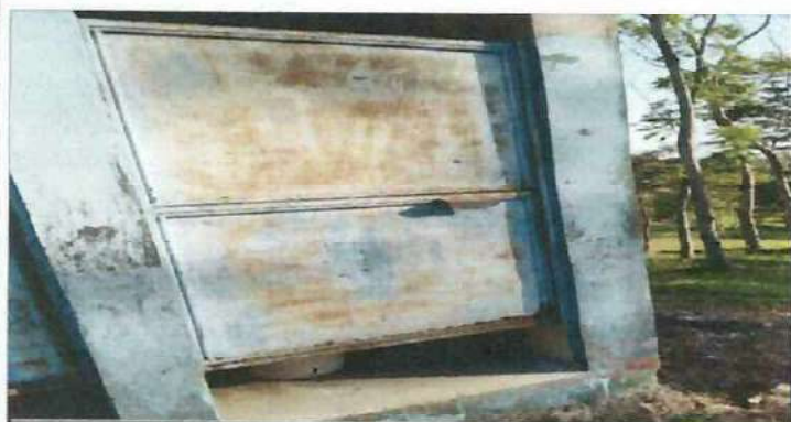
Foto 5: Las 3 puertas del sanitario estan muy deterioradas y no tienen argollas para dejarlo bajo llave, los fines de semana y las vacaciones.
