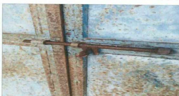
Foto 6: Son 2 puertas principales, doble hojas, muy oxidadas. Necesario alijado y pintado.
